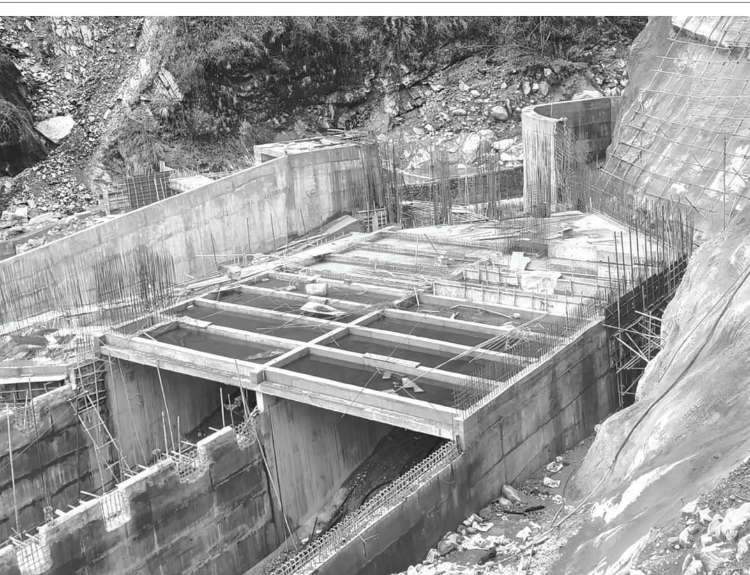
माथिल्लो ढुलोखोला 'ए' जलविद्युतको बाँधस्थल: म्याग्दीको रघुगंगा गाउँपालिका-७ र ८ को सिमा क्षेत्रमा निर्माणाधीन माथिल्लो ढुलोखोला 'ए' जलविद्युत आयोजनाको बाँध निर्माण गरिँदै । ढुलोखोला हाइड्रोपावर लिमिटेडले निर्माण गर्न लागेको २२ दशमलव पाँच मेगावाट क्षमताको यस आयोजनाको निर्माण कार्य अन्तिम चरणमा पुगेको छ ।
